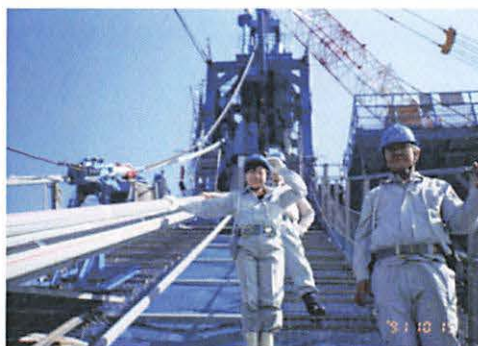
明石架橋 ケーブル足場
