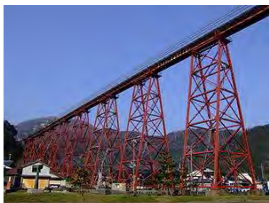
(旧) 余部鉄橋鋼製トレスル橋
